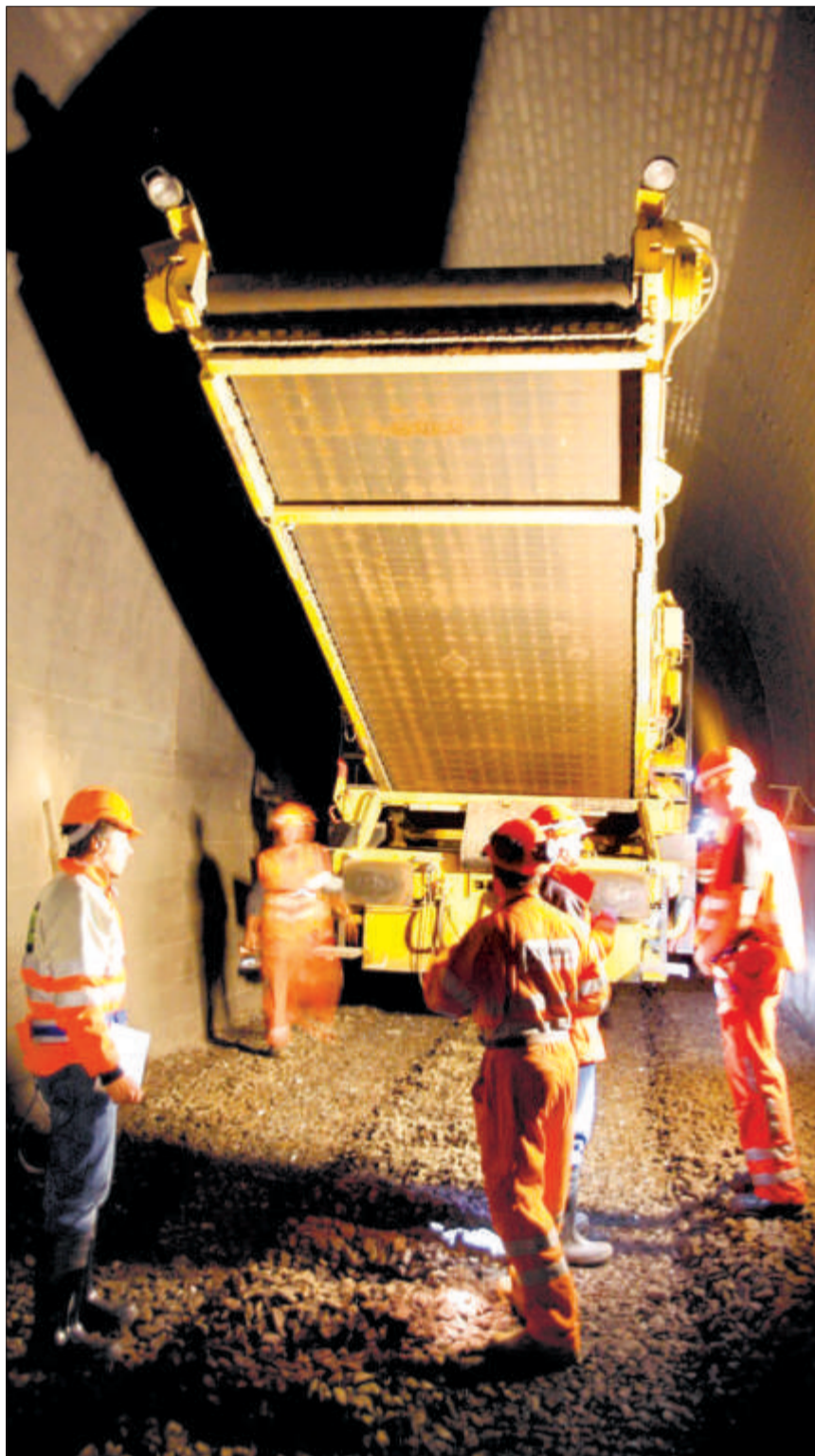
Bauarbeiten im knapp 3 Kilometer langen Fronalptunnel der SBB. Zurzeit wird das 60 Jahre alte Schotterbett ausgewechselt.
